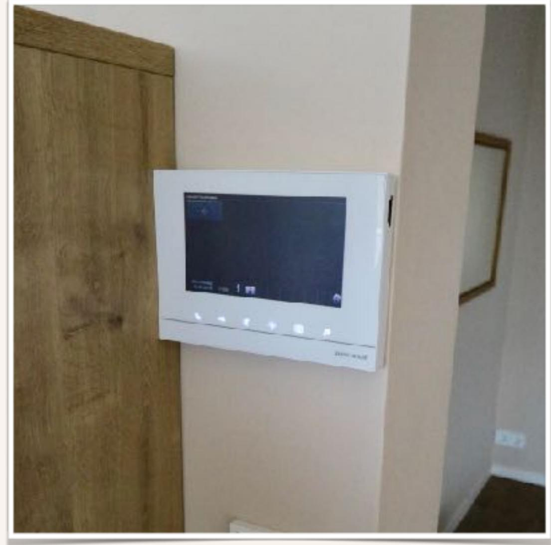
Die Videosprechanlage mit automatischer Foto-Funktion bei Klingeln der Marke Busch-Jäger ist gleichzeitig die Zentrale der Smart-Home-Option der Wohnung.
